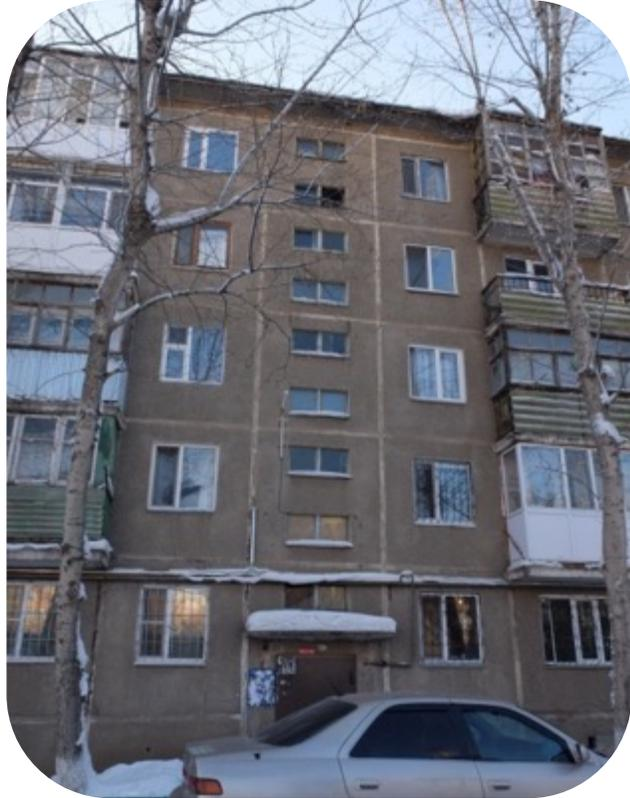
Пятиэтажное крупнопанельное здание с техническим подвалом прямоугольной формы в плане
