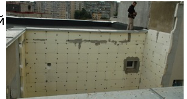
Примеры с огнеупорными слоями из минеральной ваты
