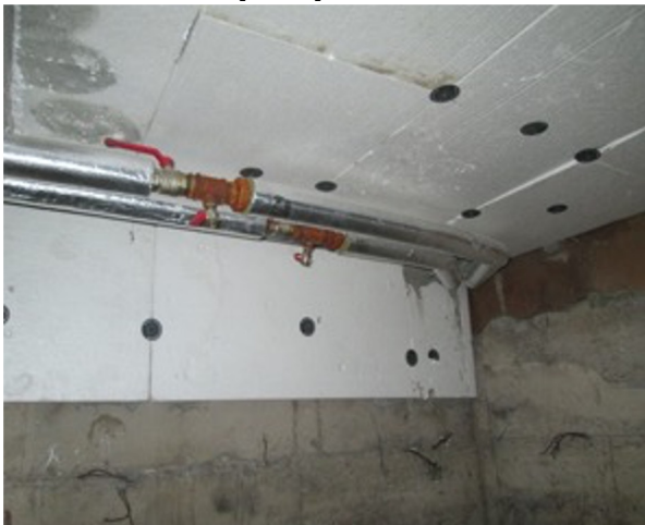
Использование EPS для изоляции подвальных перекрытий
