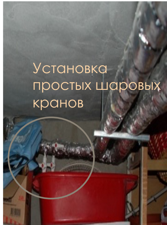
Некачественный технический монтаж
