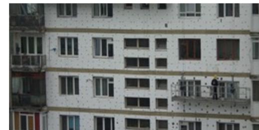
Примеры с огнеупорными слоями из минеральной ваты
