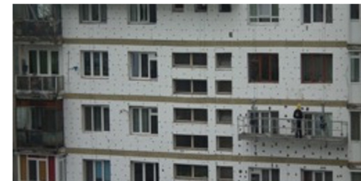
Примеры с огнеупорными слоями из минеральной ваты
