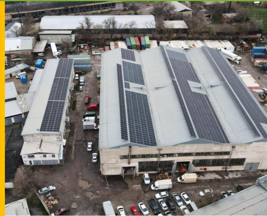
📍 Складские помещения, сетевая СЭС, г. Шымкент, 2024 г. Заказчик нарастил мощность ранее установленной СЭС.
