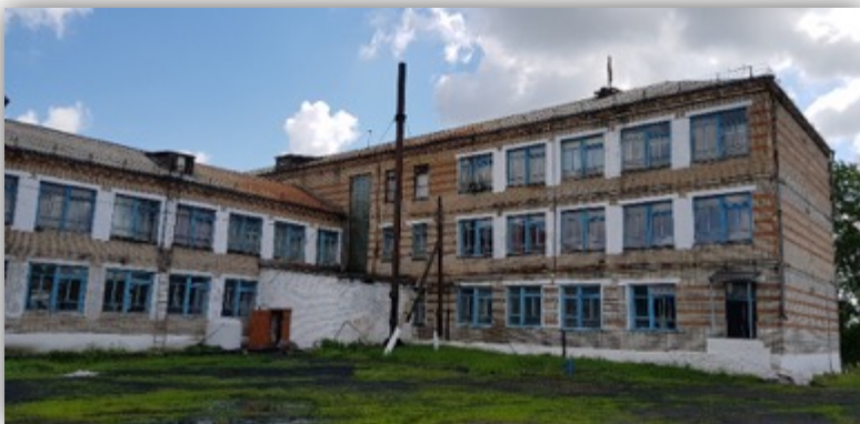
Старая котельная на угле
