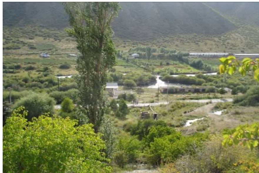
Здание малой ГЭС
