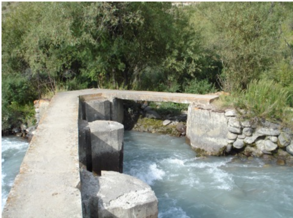
Головное водозаборное сооружения
