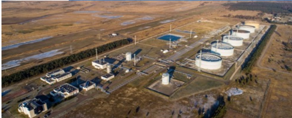
Būdingės Oil Terminal
